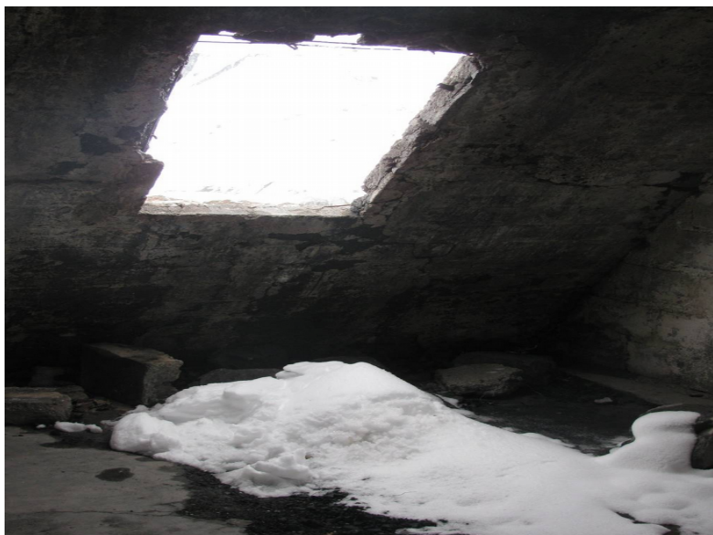
Figura 8. Interior pabellón obrero ex campamento Embalse el Yeso. (Fotografías de la autora).
